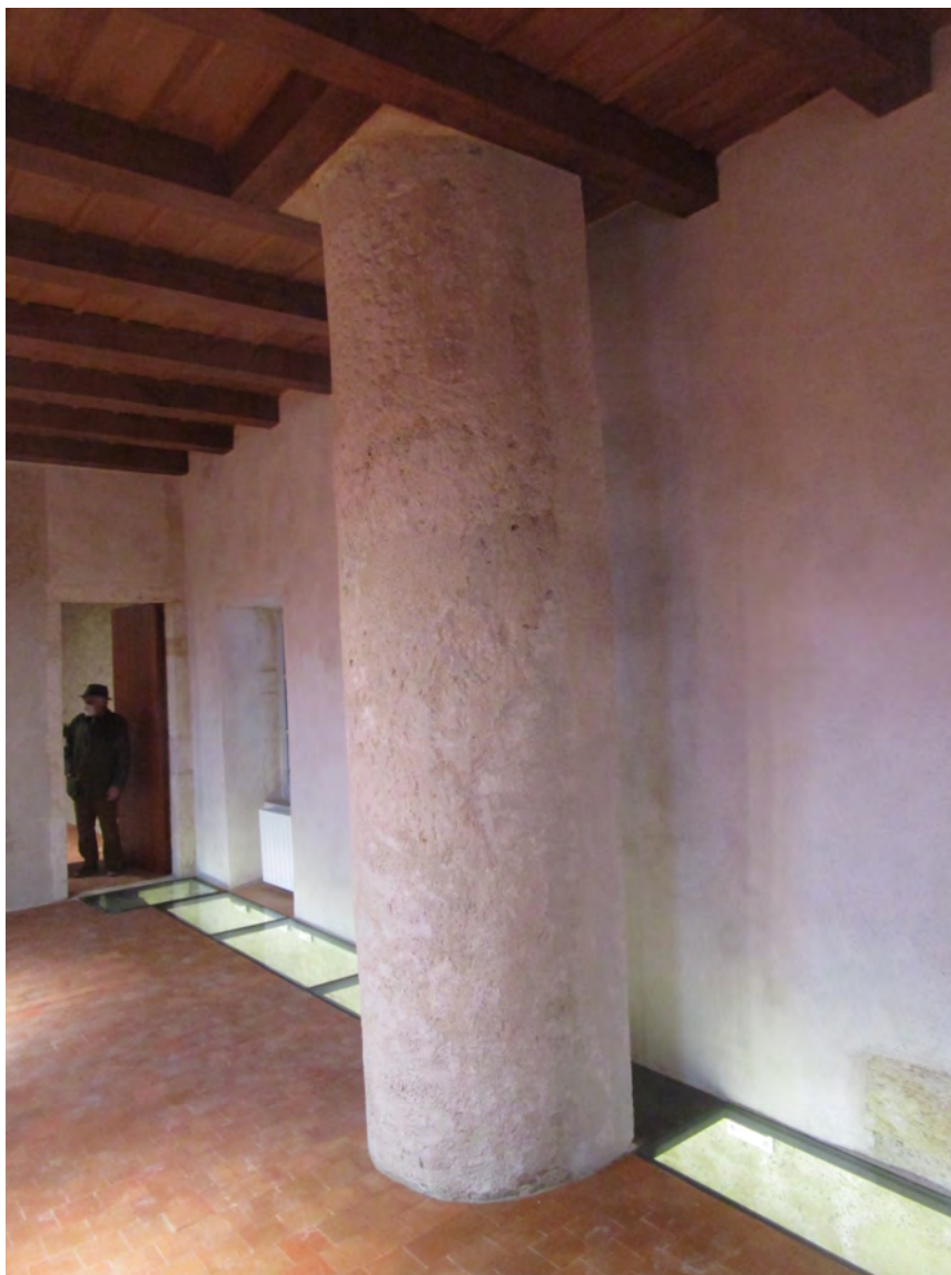
Photo 5 : Le conduit de cheminée romane
